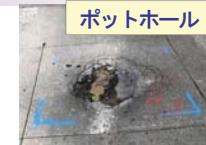
上面 3 cm 土砂化
