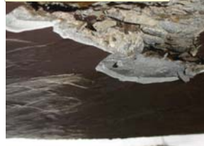
上部工のひび割れ
