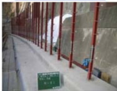
③支柱建込・壁面材取付
