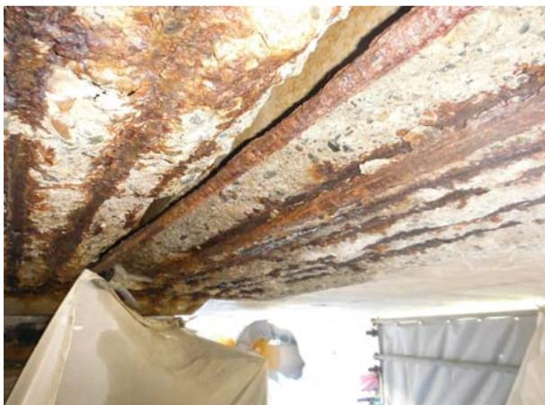
桁端部の損傷状況（はつり前）
